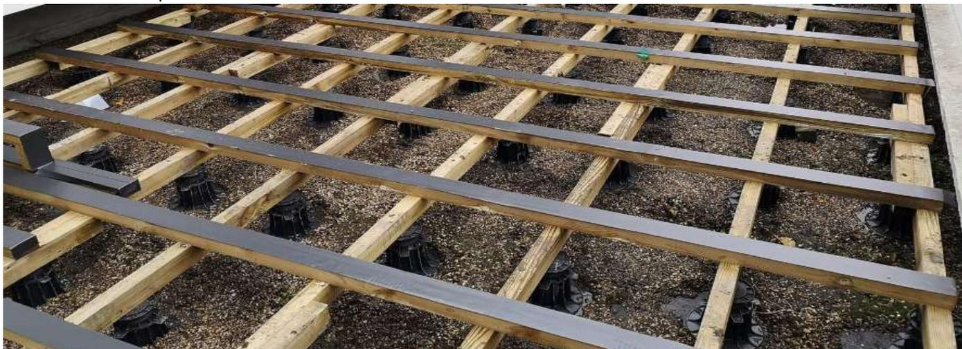
Etapes de la réalisation d'une surface adaptée à recevoir une terrasse bois : - Décaisser le sol sur 10 cm (décaper la terre végétale et enlever les éventuelles mottes de gazon), - Rappporter au moins 10 cm de gravier pour drainer la surface. Régler la planéité du sol grâce à une règle en ménageant une légère pente (1 cm / m) en direction du terrain pour favoriser l'écoulement des eaux de pluie. Tasser l'ensemble pour obtenir une portance minimale d'environ 2 bars (utiliser une plaque vibrante).
